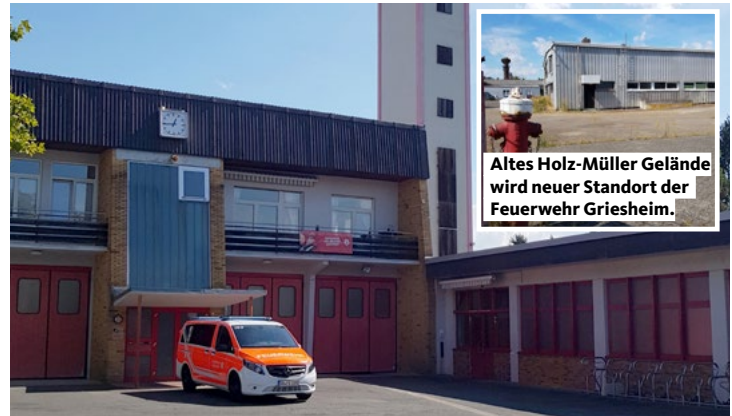
Bestehende Feuerwache und das neue Grundstück, Foto: CDU Griesheim
